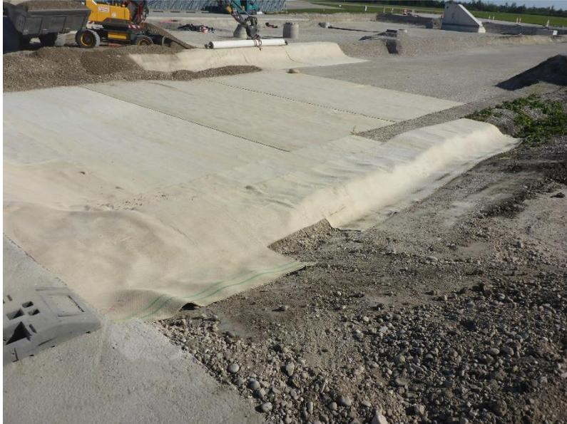
Abbildung 7: Beispiel für verlegte Bentonitmatten
