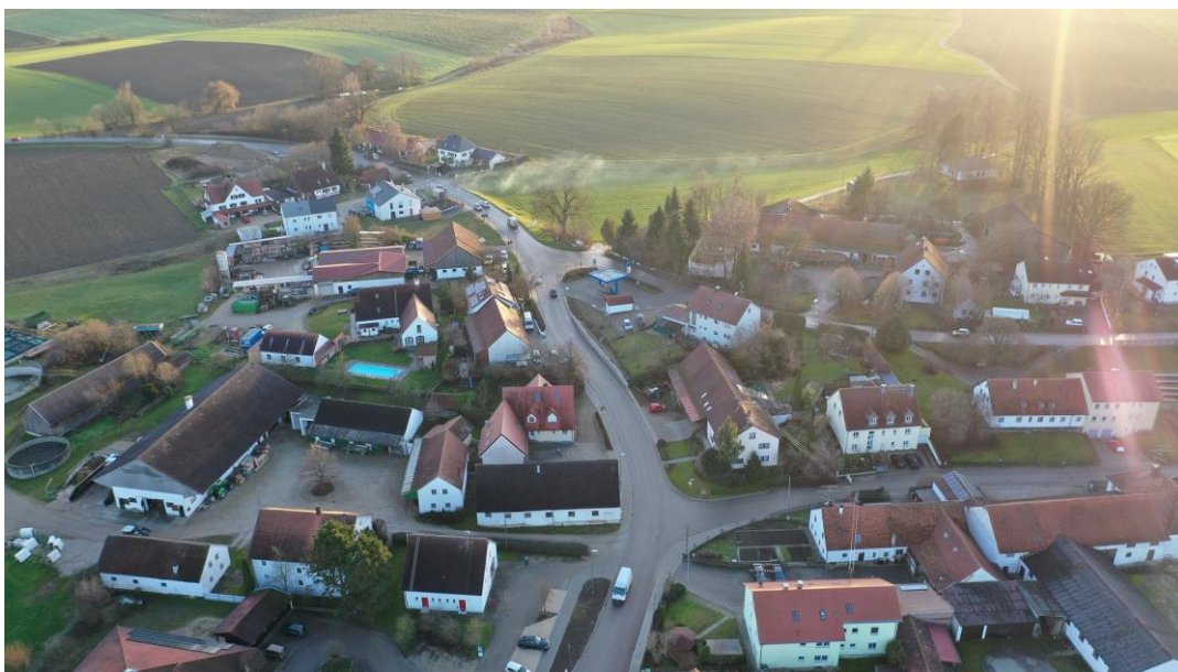
Foto 2: Bereits ausgeführte Bauabschnitte 1 und 2.
